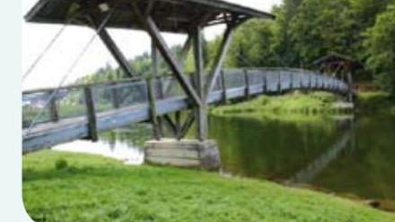
Le **portique** (passerelles, ponceaux, ponts), notamment construit sur place, permet évidemment de s'adapter plus facilement au rapport de forme (l/h) « naturel » du cours d'eau. Les matériaux utilisés peuvent être
